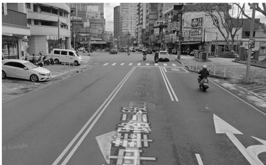
圖三、現狀路面之「機車停等區」僅繪製於車道右側，左側（內側）車道缺乏對應之停等空間
