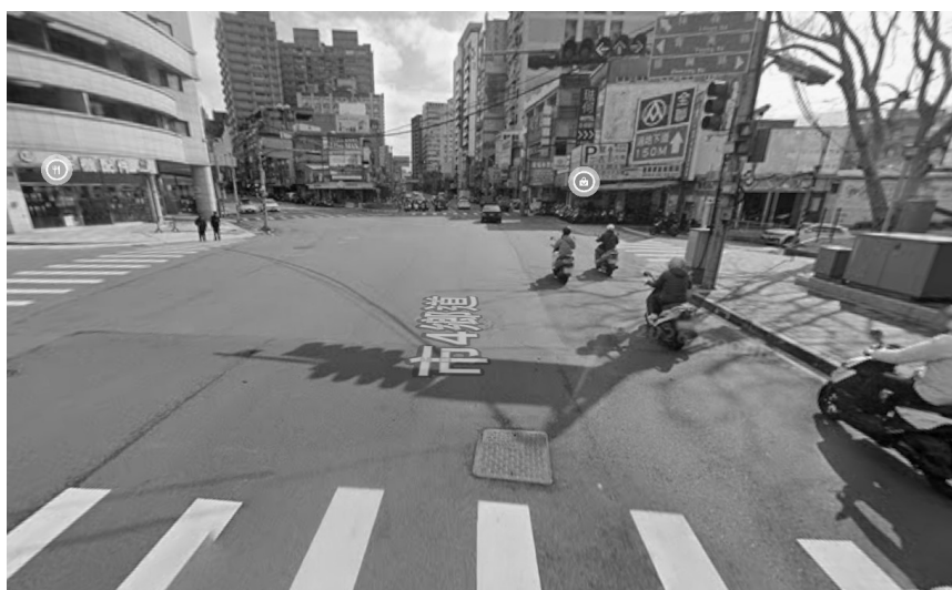
圖二、路口未設置機車兩段式左轉標誌
