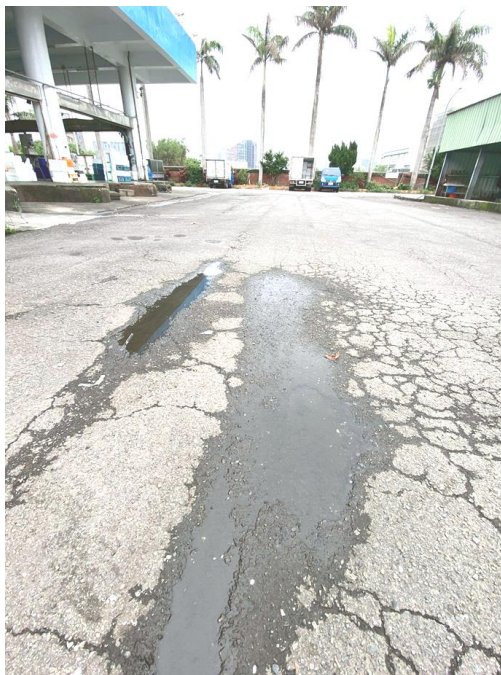
圖七、大面積龜裂
