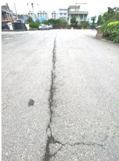
圖五、縱向長裂縫
