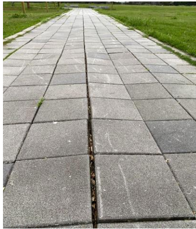
圖二、地磚間隙過大
