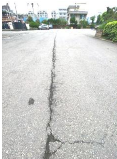
圖五、縱向長裂縫
