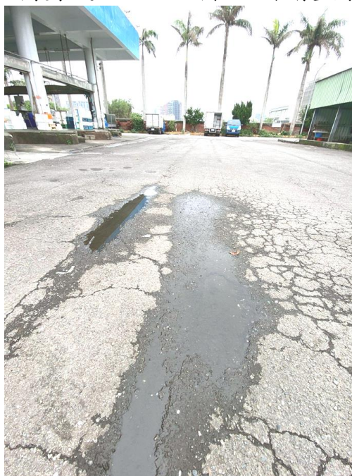
圖七、大面積龜裂
