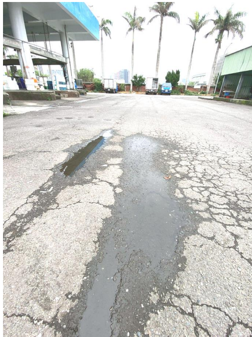
圖七、大面積龜裂
