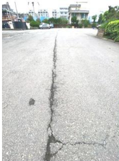
圖五、縱向長裂縫
