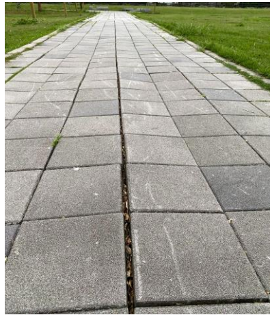
圖二、地磚間隙過大
