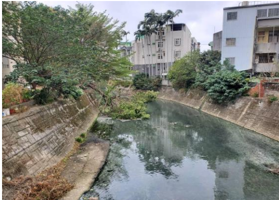
圖二、大型樹木倒伏於溝渠中
