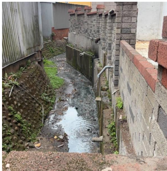
圖三、武陵路 159 號前的水溝
