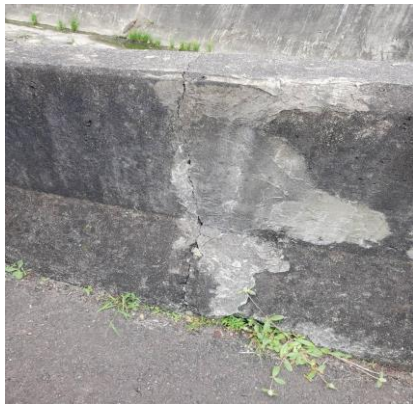
圖一、混凝土出現明顯裂痕。 圖二、建議改為人行道區。
