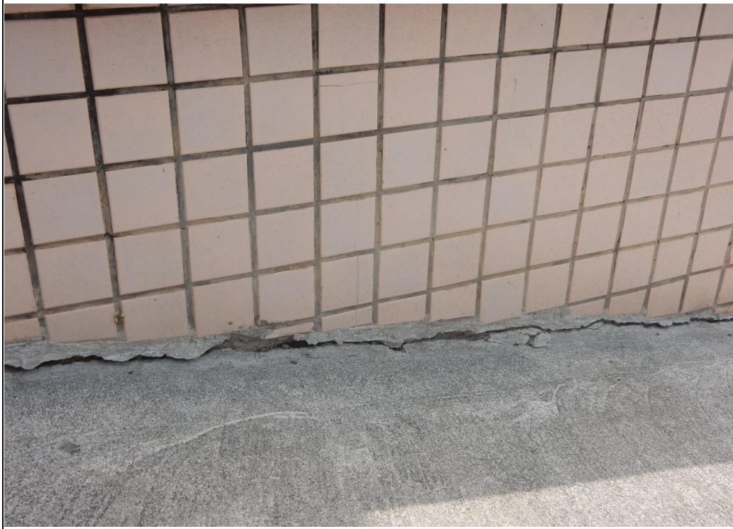
學校司令台老舊地基龜裂照片
