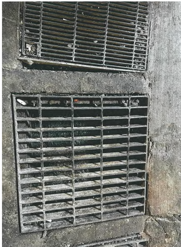
圖三、市場內排水系統老舊且長期淤積
